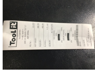
Elektrik donanımı/Pano, Akü > Test Sonucu
