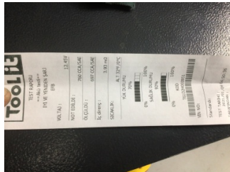
Elektrik donanımı/Pano, Akü > Test Sonucu
