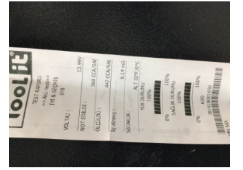
Elektrik donanımı/Pano, Akü > Test Sonucu
