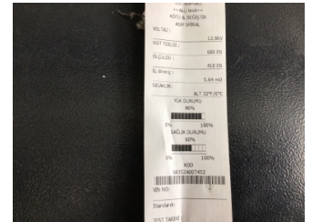
Elektrik donanımı/Pano, Akü > Test Sonucu
