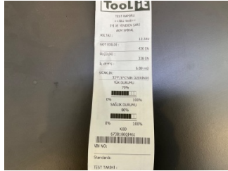
Elektrik donanımı/Pano, Akü > Test Sonucu
