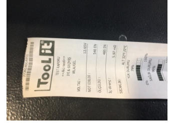
Elektrik donanımı/Pano, Akü > Test Sonucu
