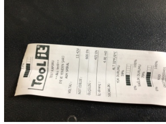
Elektrik donanımı/Pano, Akü > Test Sonucu
