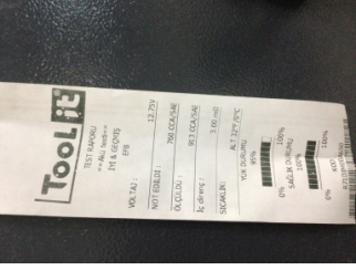
Elektrik donanımı/Pano, Akü > Test Sonucu
