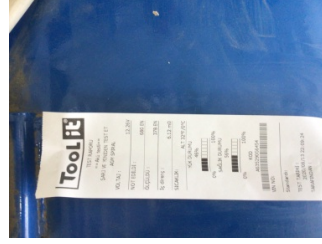
Elektrik donanımı/Pano, Akü > Test Sonucu
