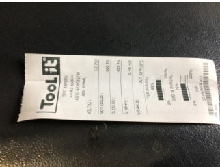
Elektrik donanımı/Pano, Akü > Test Sonucu
