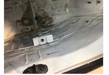
Arka bölüm, Bagaj havuzu > Hasarlı
