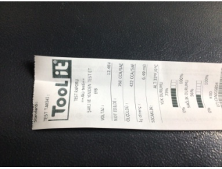
Elektrik donanımı/Pano, Akü > Test Sonucu
