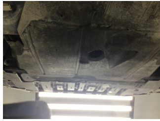
Motor, Alt muhafaza > Hasarlı
