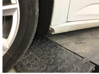
Marşbiyel, sol, Marşbiyel, sol > Hasarlı
