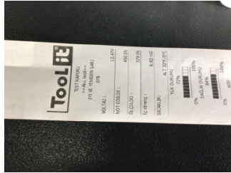
Elektrik donanımı/Pano, Akü > Test Sonucu
