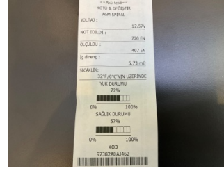
Elektrik donanımı/Pano, Akü > Test Sonucu
