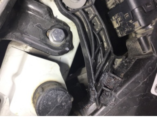
Farlar, Far, sol > Standart Dışı Onarım
