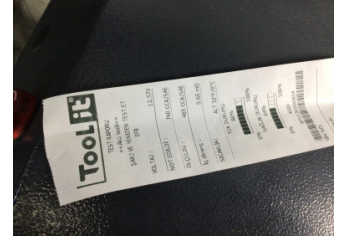
Elektrik donanımı/Pano, Akü > Test Sonucu
