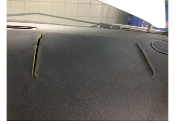
Emniyet sistemleri/Hava yastıkları, Yolcu hava yastığı > Hasarlı
