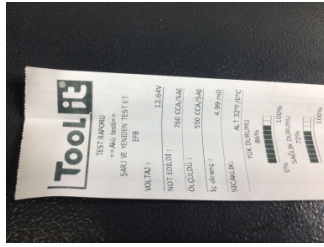
Elektrik donanımı/Pano, Akü > Test Sonucu
