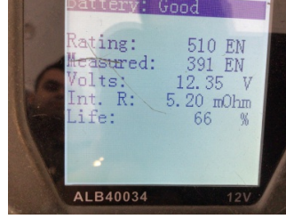
Elektrik donanımı/Pano, Akü > Test Sonucu
