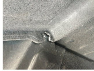
Döşemeler/Kapaklar, Pandizot > Eksik
