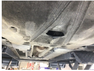
Motor, Alt muhafaza > Hasarlı
