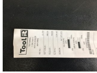
Elektrik donanımı/Pano, Akü > Test Sonucu
