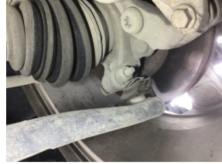
Ön aks, Salıncak, ön sol alt > Deforme Olmuş
