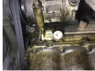
Motor, Silindir kapağı > Yağ Kaçağı
