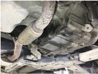
Şanzıman, Şanzıman > Yağ Kaçağı
