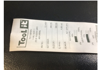
Elektrik donanımı/Pano, Akü > Test Sonucu
