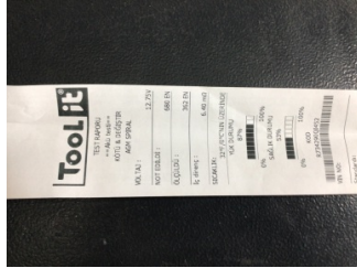
Elektrik donanımı/Pano, Akü > Test Sonucu
