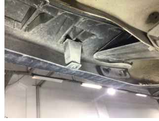
Tampon, arka, Bağlantı ayağı > Hasarlı
