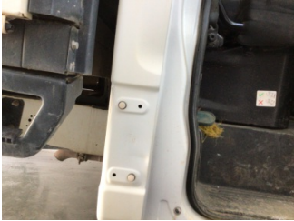
Kapı, sağ arka, Kapı bandı > Sökülmüş-Yok
