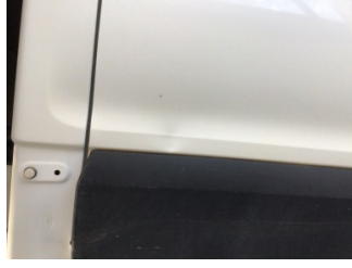
Kapı, sağ arka, Kapı, sağ arka > Ezik
