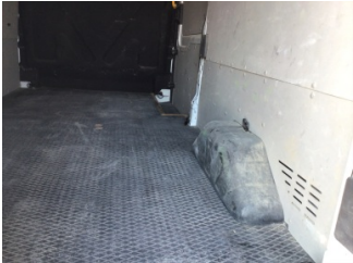
Döşemeler/Kapaklar, Döşemeler/Kapaklar > Çizik
