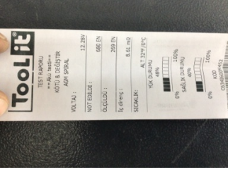
Elektrik donanımı/Pano, Akü > Test Sonucu
