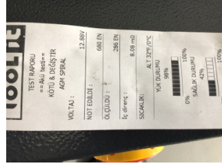
Elektrik donanımı/Pano, Akü > Test Sonucu
