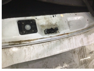
Arka bölüm, Arka sac/panel > Standart Dışı Onarım
