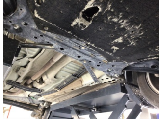
Motor, Alt muhafaza > Hasarlı
