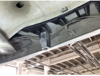
Tampon, arka, Bağlantı ayağı > Hasarlı
