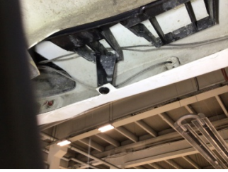
Tampon, arka, Bağlantı ayağı > Hasarlı
