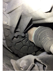
Şanzıman, Şanzıman > Yağ Kaçağı
