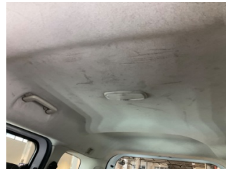
Döşemeler/Kapaklar, Tavan döşemesi > Deforme Olmuş
