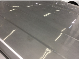
Tavan, Tavan > Hasarlı
