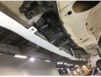
Tampon, arka, Bağlantı ayağı > Hasarlı
