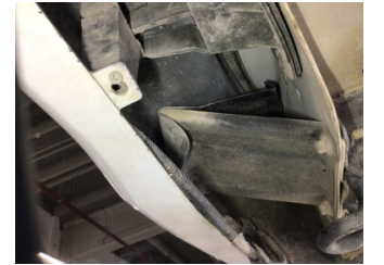
Tampon, arka, Bağlantı ayağı > Hasarlı
