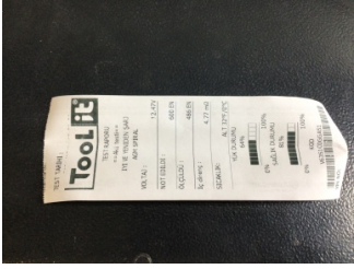
Elektrik donanımı/Pano, Akü > Test Sonucu
