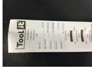
Elektrik donanımı/Pano, Akü > Test Sonucu
