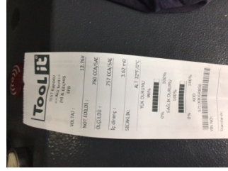
Elektrik donanımı/Pano, Akü > Test Sonucu
