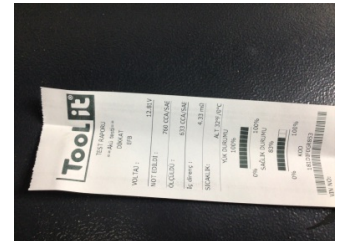
Elektrik donanımı/Pano, Akü > Test Sonucu
