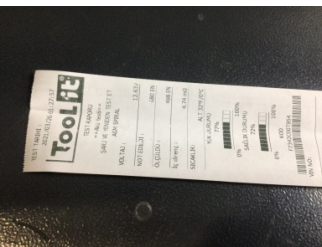
Elektrik donanımı/Pano, Akü > Test Sonucu
