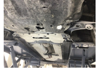
Motor, Alt muhafaza > Hasarlı
