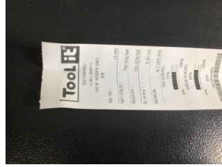
Elektrik donanımı/Pano, Akü > Test Sonucu
