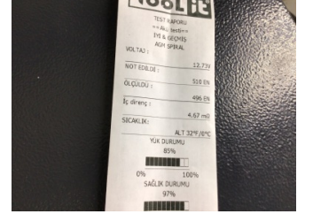
Elektrik donanımı/Pano, Akü > Test Sonucu
